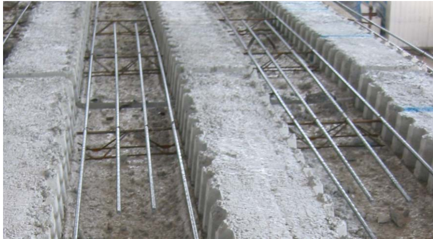
Bild 8.28: Eingelegte Stützbewehrung in die Stegzwischenräume
