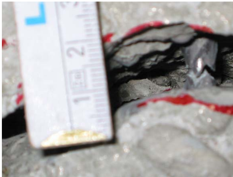
Bild 8.31: Gerissene Stützbewehrung
