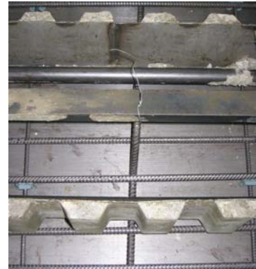
Bild 8.7: Eingebauter Transporthaken
