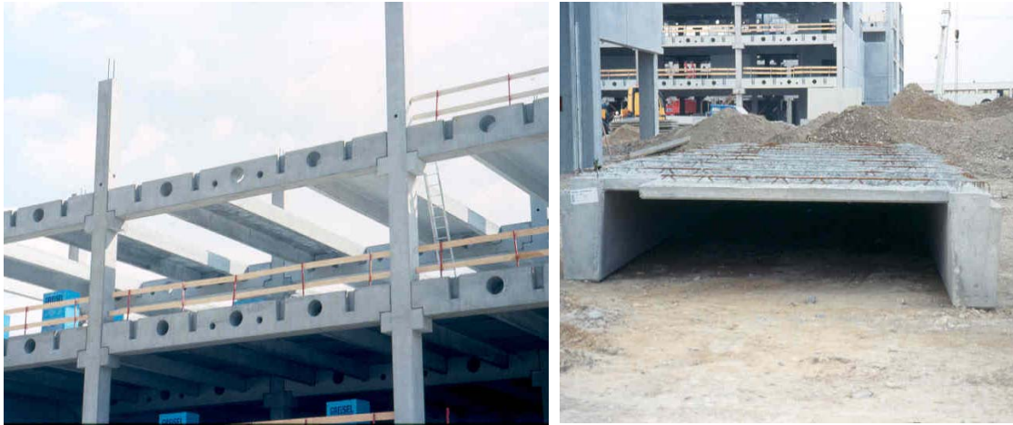
Bild 2.6: Trogplattendecke
