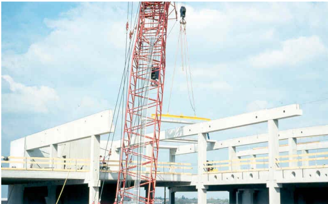
Bild 2.5: Spannbeton-Hohldielen als Dachkonstruktion
