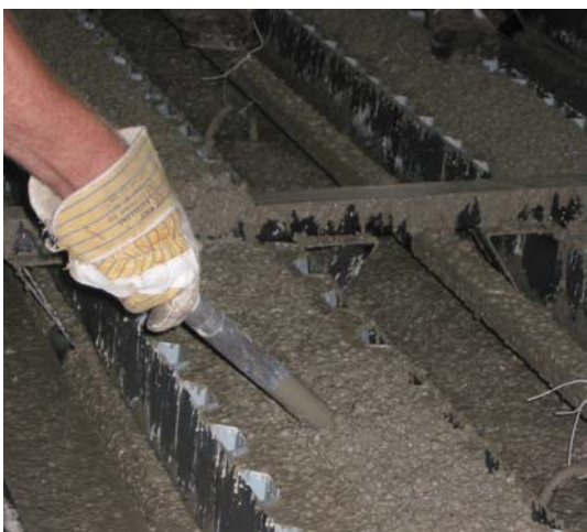
Bild 8.9: Verdichten der Stege
