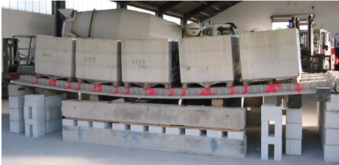
Bild 8.20: Durchbiegung einer SVP der Betongüte C 30 bei 95 % des Bruchmoments
