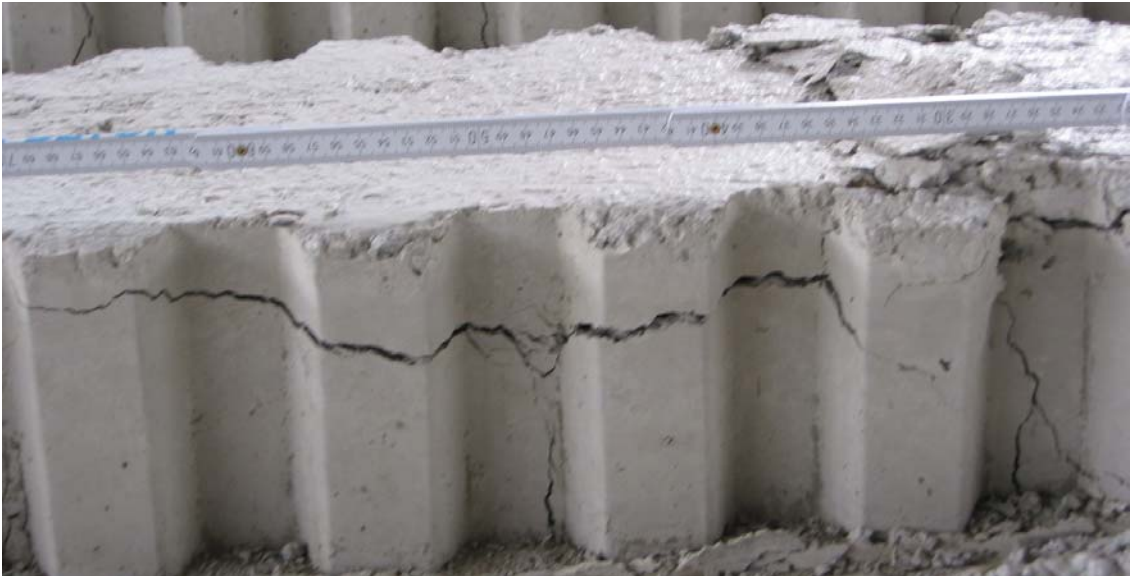
Bild 8.21: Versagen der Druckzone bei einer Stegverbundplatte der Betongüte C 30
