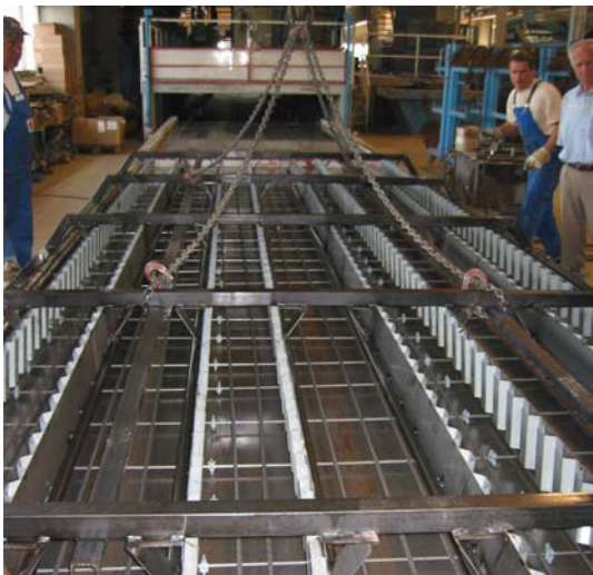
Bild 8.8: Auflegen der Schalung
