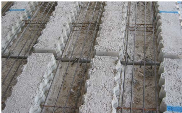
Bild 2.12: Eingelegte Stützbewehrung einer einachsigen Spannteile über zwei Feldern
