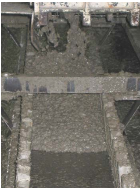
Bild 8.13: Verfüllen der Stege mit hochfestem Beton
