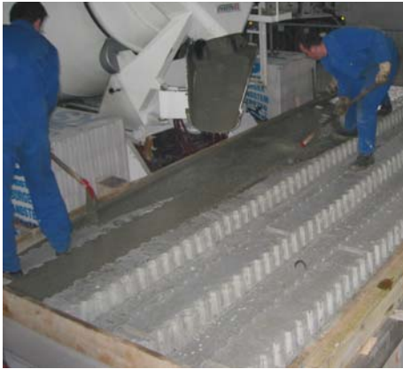
Bild 8.14: Aufbringen der Ortbetonergänzung
