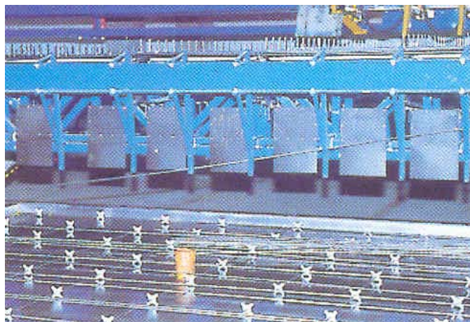
Bild 6.2: Verlegen der Plattenbewehrung
